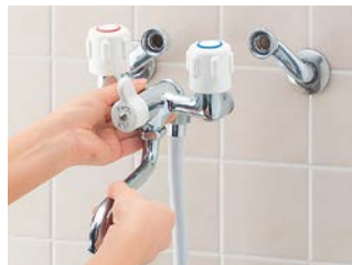
止水栓を締めて脚を残したまま2ハンドル水栓の本体を取り外します。
