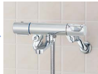
サーモスタット付水栓本体を取り付けます。
